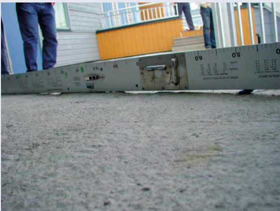
Svalgangsdekke med grovt "børstet" overflate. Ruheten er så stor at beboere snubler i overflaten. Foto: SINTEF Byggforsk.
