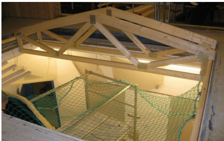
Tak under montering i lydlaboratoriet ved SINTEF Byggforsk. Foto: SINTEF Byggforsk
