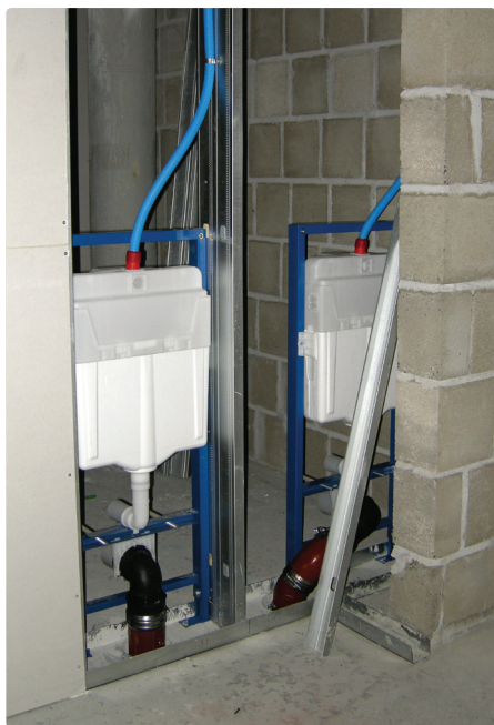
Sanitærutstyr under montasje.
