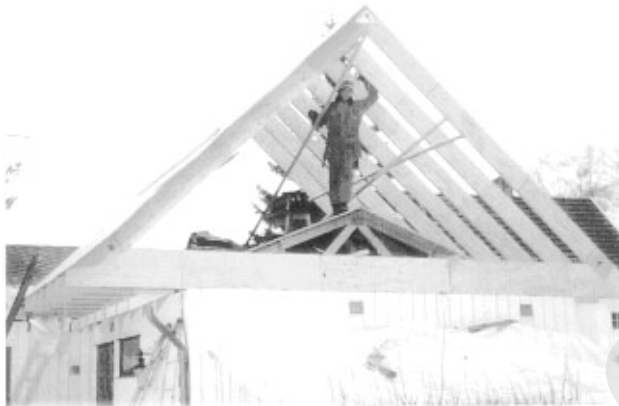
Fig. 43 b Monterbare takbind av parallellfinér under reising. Eksisterende tak beholdes til det nye er montert og tekket. (Foto: arkitekt, bygningsingeniør Tore Staver)
