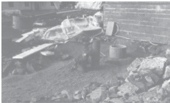
Fig. 213 a Kummer på sekundærnettet plassert i terrenget mellom hus
