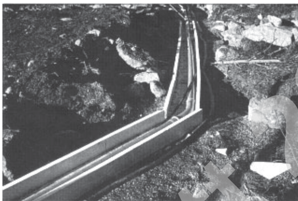
Fig. 21 Ledninger lagt på eksisterende terreng. Matjord er fjernet, og finpukk lagt i grøftefundamentet.
