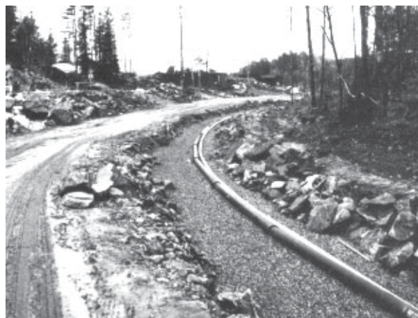
Fig. 22 b Hovedvannledning og høyspentkabler i fellesgrøft under gang-/sykkelveg ved siden av samleveggen
