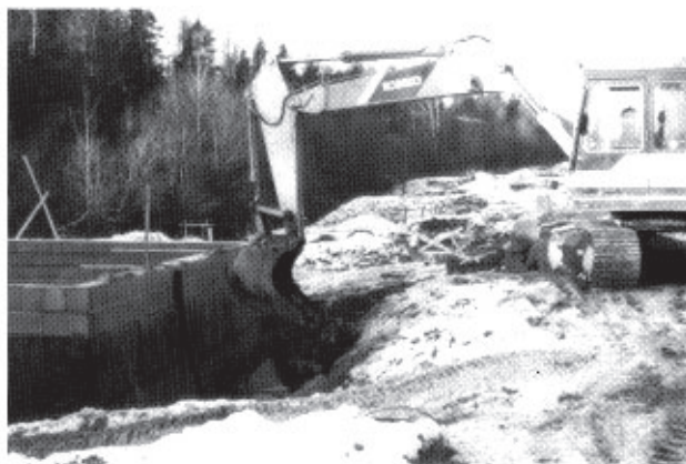
Fig. 612 a Tilbakefylling mot grunnmur og tomteplanering bør utføres før det blir lagret materialer på tomta.
