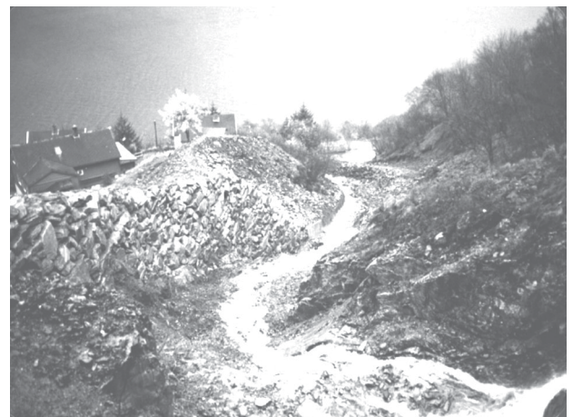
Fig. 351 Ledevoll mot flom- og sørpeskred. Sandvika i Høyanger (Foto NGI)
