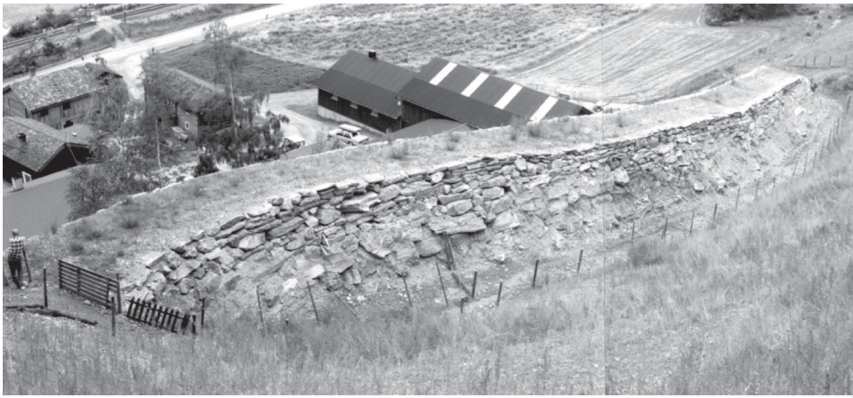
Fig. 251 Fangvoll mot steinskred. Otta i Gudbrandsdalen (Foto NGI)
