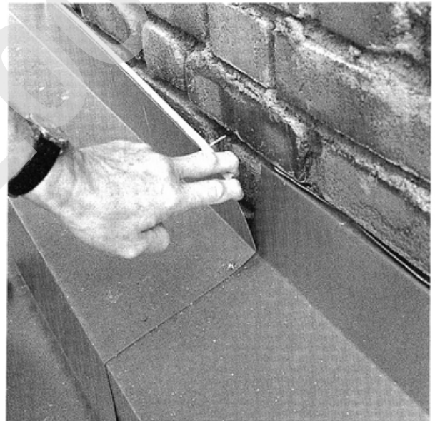
Fig. 311 b Utett innføringsfuge i teglvegg
