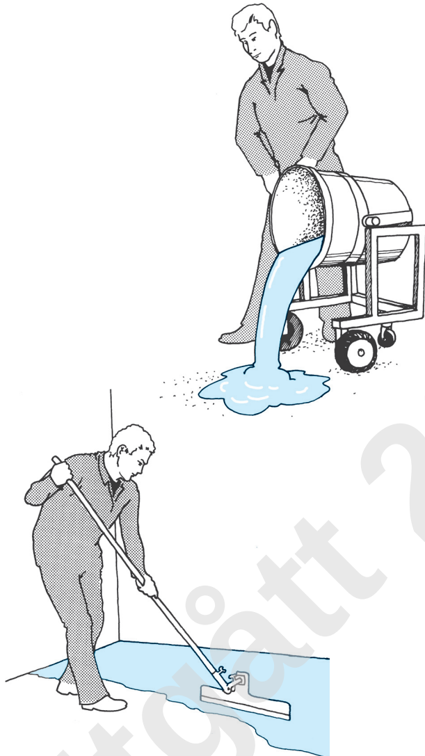
Fig. 73 c Utlekking av selvutjevne masse Massen helles ut av blandedekaret, flyter lett utover golvet og fordeles med nivårake eller tannsparkel.
