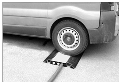
Fig. 33 Eksempel på beskyttelse av kabel på bakken. Foto: Byggstrøm
