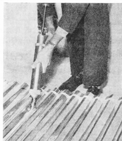
Fig. 04 c Fugemasse påført med sprøytepipstol
