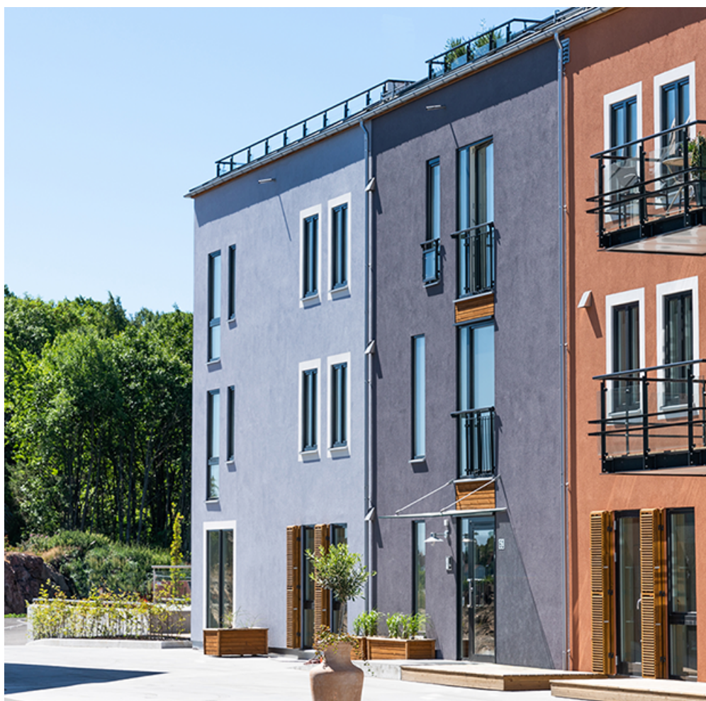
Eksempel på fasadesystem med puss på utlektede plater. Sjøparken, Stavern. Arkitekt: Mer Arkitektur AS. Foto: Cecilie Sanden
